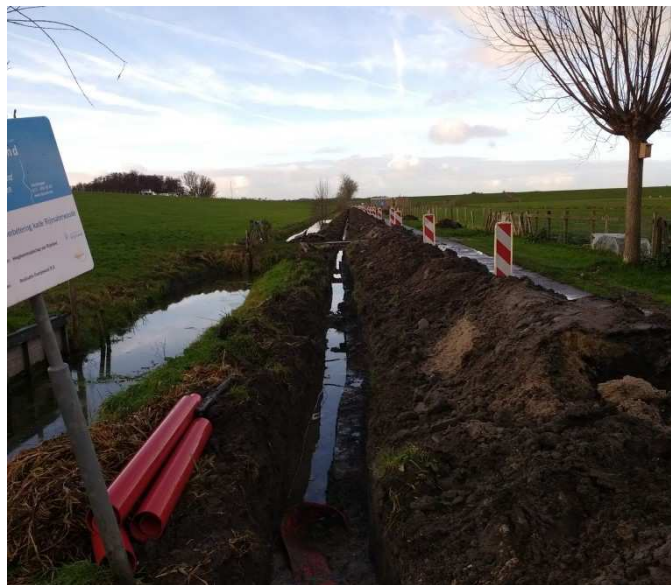
Sleuf voor elektriciteitskabel AWTG Rijnsaterwoude
