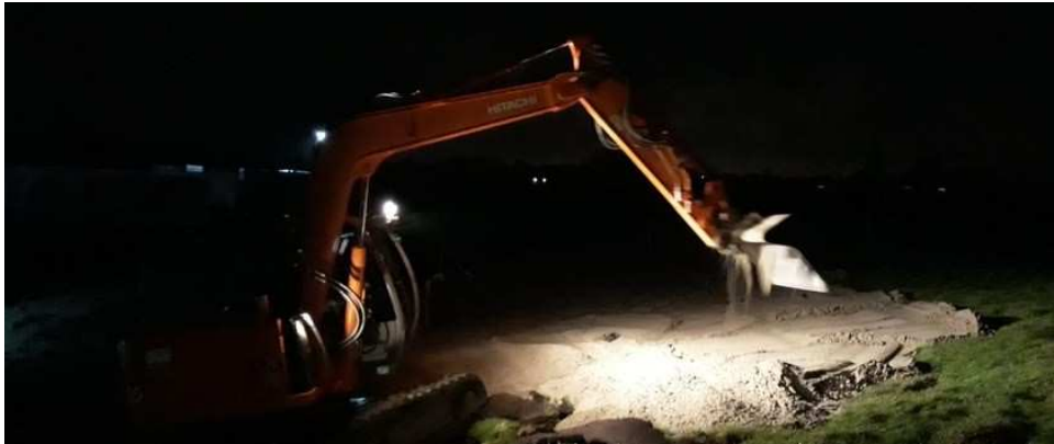
Herstel van de laatste calamiteit in 2018: in het weekend voor kerstmis werd een veenkade met spoed hersteld.
