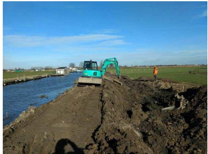
Kadeversterking Hemmeerpolder (regionale kering) in uitvoering
