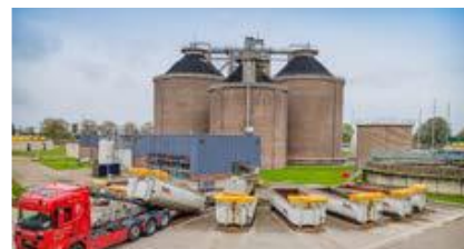
Figuur 3: Na vergisting in torens, ontwatering en afvoer van zuiveringsslib
