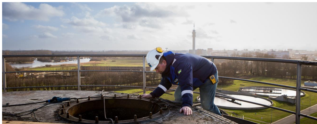
Figuur 8: Renovatie slibvergistingstoren op zuivering Haarlem Waarderpolder
