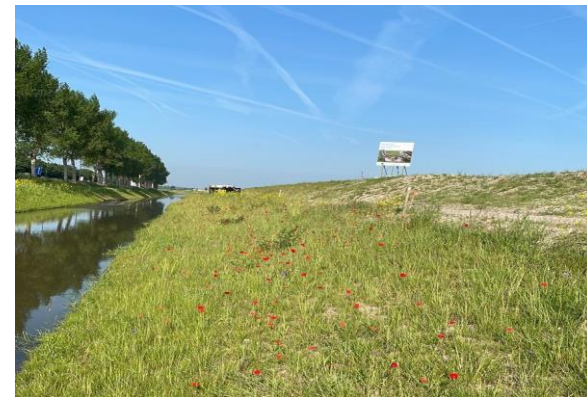
Figuur 6 Aanleg natuurvriendelijke oever
