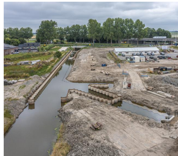
Figuur 21: Uitlaatkanaal en bouwkeet
