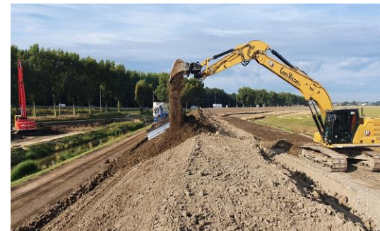
Figuur 11: Werkzaamheden aan de kade
