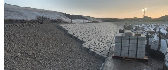
Figuur 15: Aanbrengen basaltblokken woelkom
