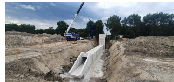
Figuur 10: Doorlaat Nieuwkerkertocht (Oost)
