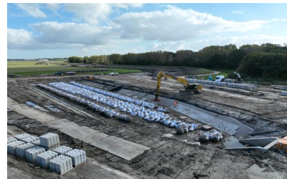
Figuur 14: de woelkom in uitvoering
