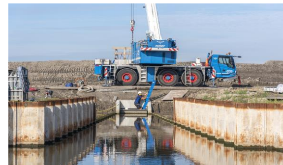
Figuur 8: Plaatsen afsluiters uitlaatconstructie
