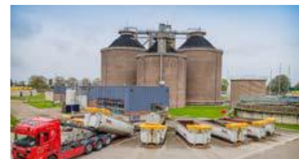
Figuur 3: Na vergisting in torens, ontwatering en afvoer van zuiveringsslib
