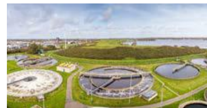
Figuur 2: Waterzuivering: voorbezinktank (1x), beluchtingstank (2x), nabezinktank (4x)
