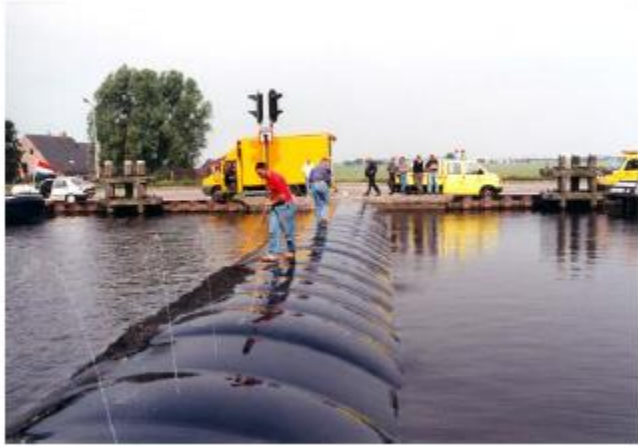
Figuur 1: Balgstuw in werking
