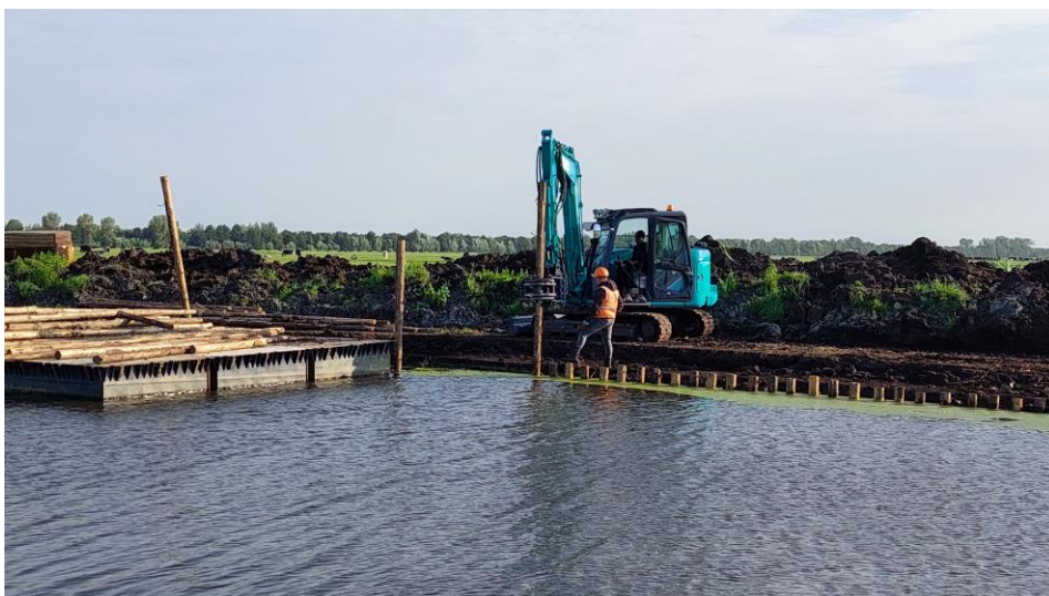
Aanbrengen palenrij om het talud te versterken.
