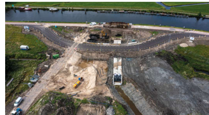
figuur 9: bouw van de inlaatconstructie (fase 2)
