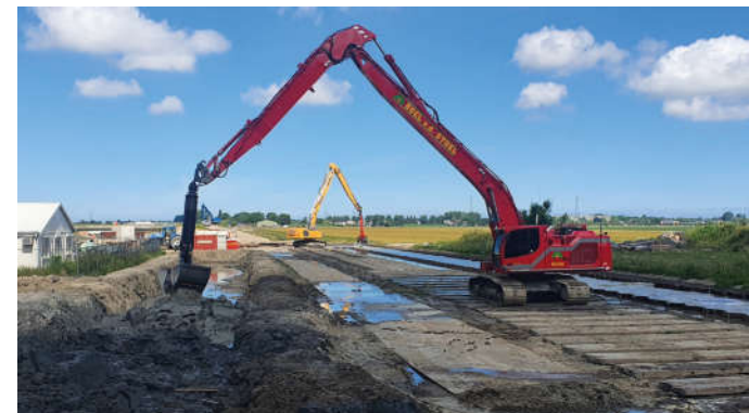
figuur 6: werk aan uitstroomkanaal
