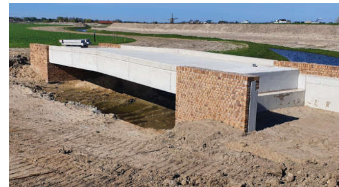
figuur 12: landbouwbrug in uitvoering
