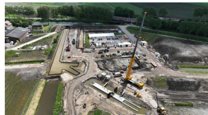
figuur 11: bouw van de uitlaatconstructie
