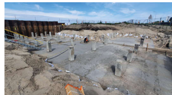
figuur 13: bouw van de inlaatconstructie
