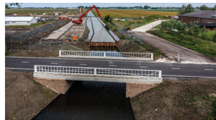
figuur 10: nieuwe brug in de Hoofdweg
