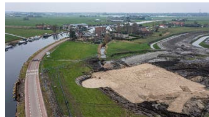
Figuur 12: De ringvaart & werkzaamheden bij de inlaatconstructie
