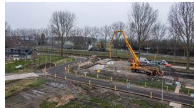
Figuur 11: De bypass en werkzaamheden brug Hoofdweg
