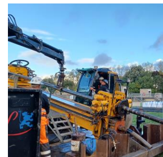
Figuur 9: Start werkzaamheden
