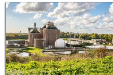
Figuur 2: De slibgistingstoren met beluchtingstank rechts in beeld en de nabezinktank links in beeld.
