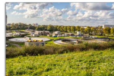
Figuur 3: De voorbezinktank, beluchtingstank en nabezinktank in beeld.
