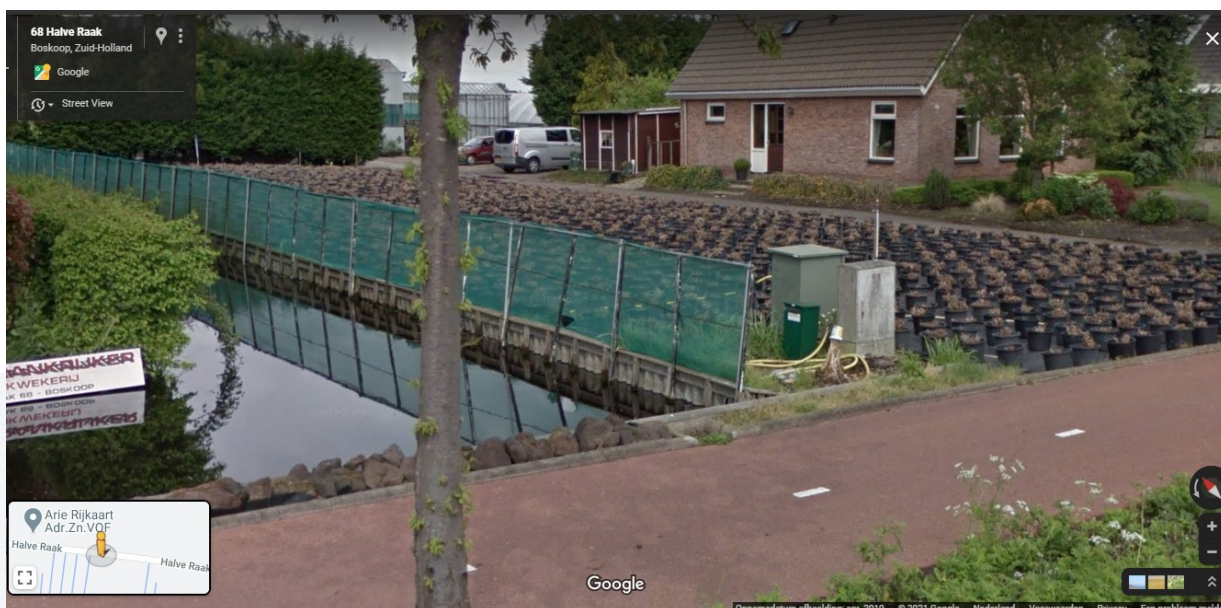
Figuur 3 Voorbeeld van peilvakscheiding die over een oeververdediging loopt.
