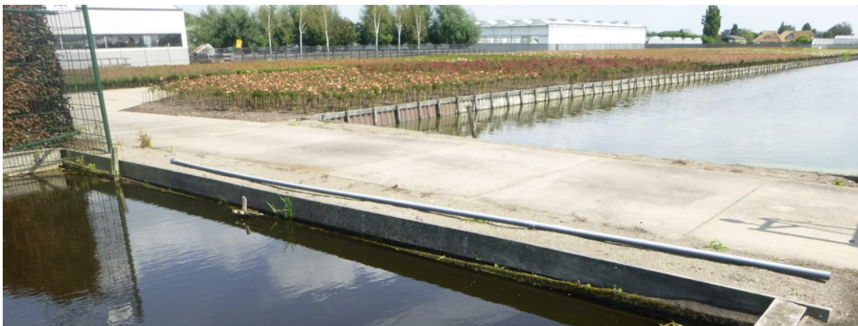
Figuur 5 Voorbeeld van een peilvakscheiding over een dam in de Gouwepolder.
