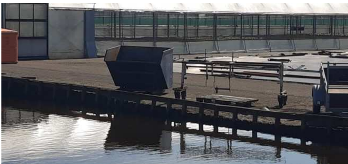
Figuur 2 Voorbeeld van lage peilvakscheiding in de Gouwepolder, waar water ook daadwerkelijk naar binnen is gestroomd bij meerdere zware regenbuien. Inmiddels is deze laagte opgehoogd.
